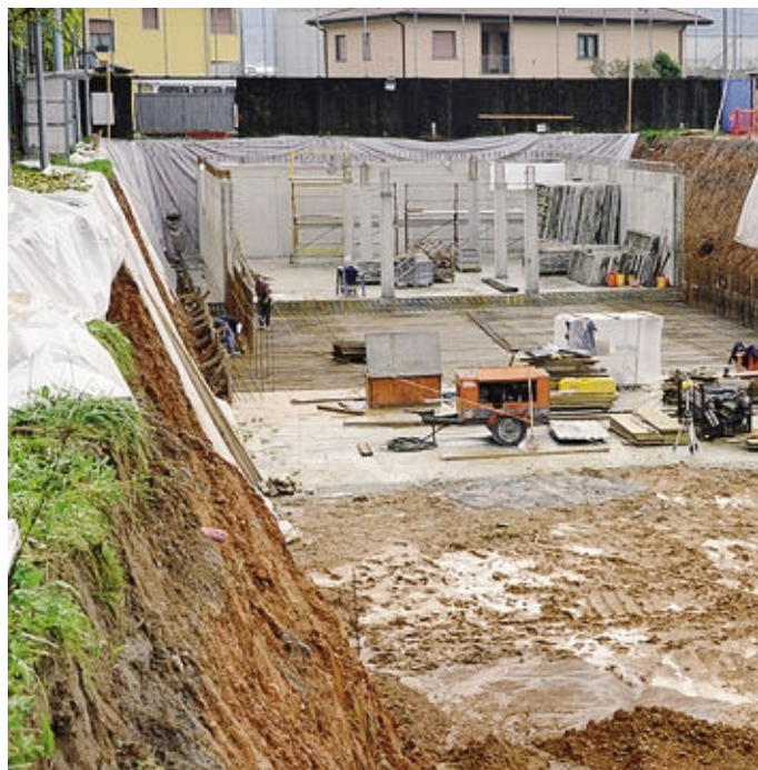
I lavori per la vasca di laminazione al campo sportivo di Casnigo
